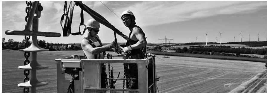
Bekommen weniger zu tun: Arbeiter an neuer Stromleitung Foto: dapd
